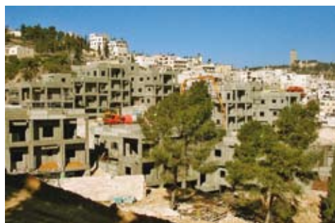
Appartements destinés à des chrétiens, en construction sur le Mont des Oliviers près du sanctuaire de Bethphagé.
